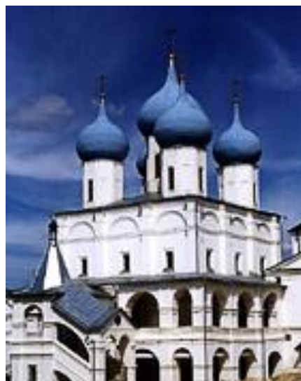
Рисунок 1 – Вид Зачатьевского собора Высоцкого монастыря
