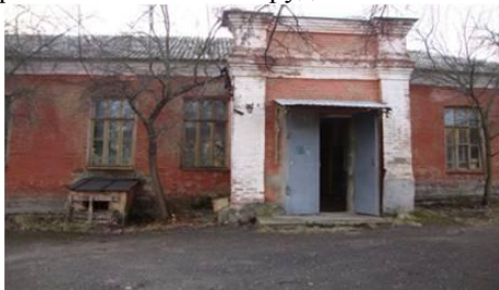
Здание бывшей начальной школы. 19 век.
